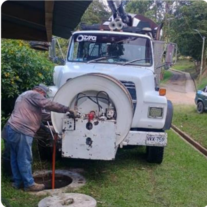
Prestación del servicio de limpieza y mantenimiento de las redes de alcantarillado sanitario y pluvial y posibles contingencias con equipo de succión- presión (vactor)
