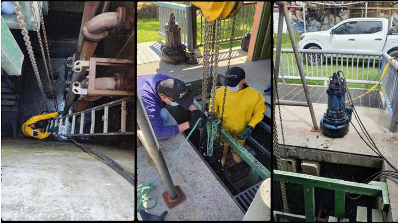
Mantenimiento preventivo y correctivo de las bombas y tablero eléctrico de control para el correcto funcionamiento de la estación de bombeo de aguas residuales (EBAR)
